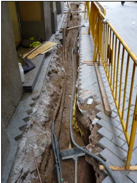
FOTO 3. Segon tram de rasa
